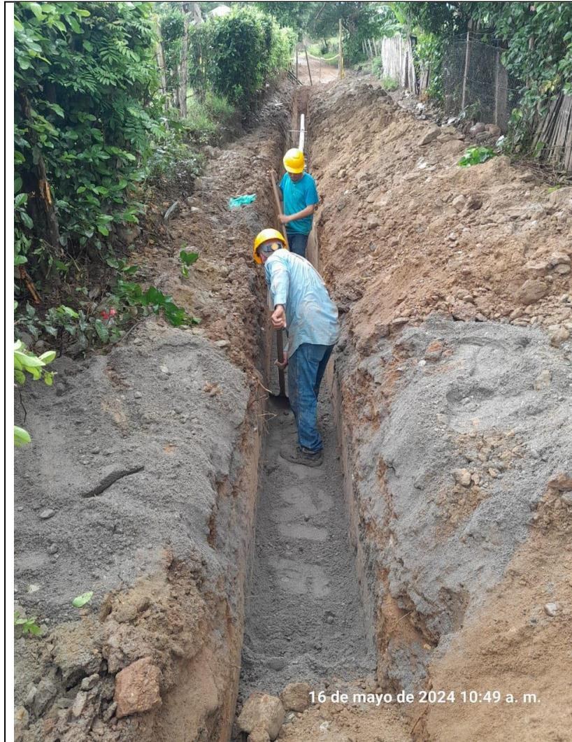
Foto 2. instalación de la tubería de conducción
