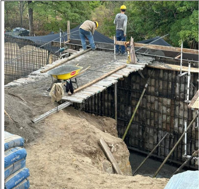
Foto 3. Fundición de muros PTAP
